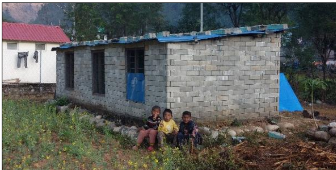
Hus byggda av earth-bricks är utan skador
